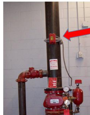
สวิตช์ตรวจจับการไหลของน้ำ (Sprinkler Water Flow)
